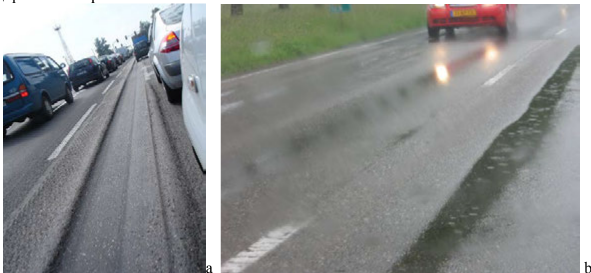
Рис. 2. Колеиность: а) колеиность на скоростной дороге № 86 между Катовице и Ченстоховой; б) колеиность в условиях дождя или снега
